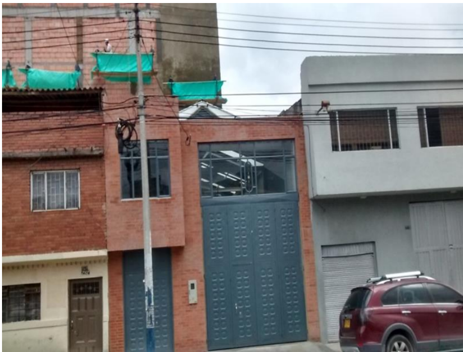
Foto .1 Estado actual del predio donde funcionaba MANTENIMIENTO AUTOMOTOR, cuya nomenclatura actual es CR 28 B # 71A -09.
